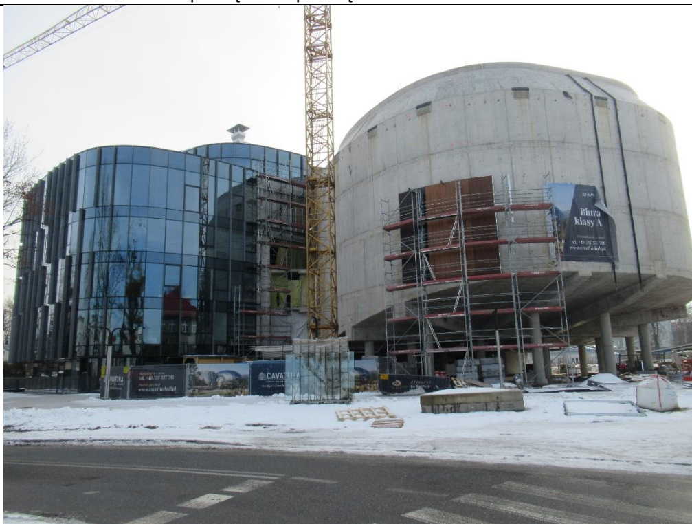
Sala koncertowa CAVATINA /w budowie/ - pomieści na widowni kilkaset osób
