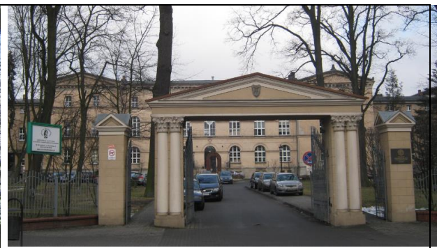
Widok na budynek szkolny przez bramę
