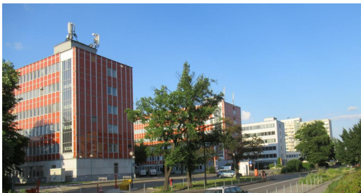
Dwa budynki dawnej ELWRO – obłożone brązowymi płytami
