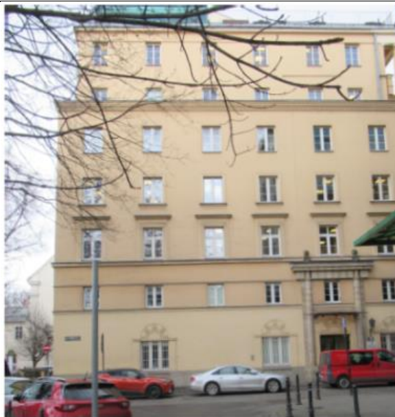
Widok budynku Akademii z ul. Św. Marka
