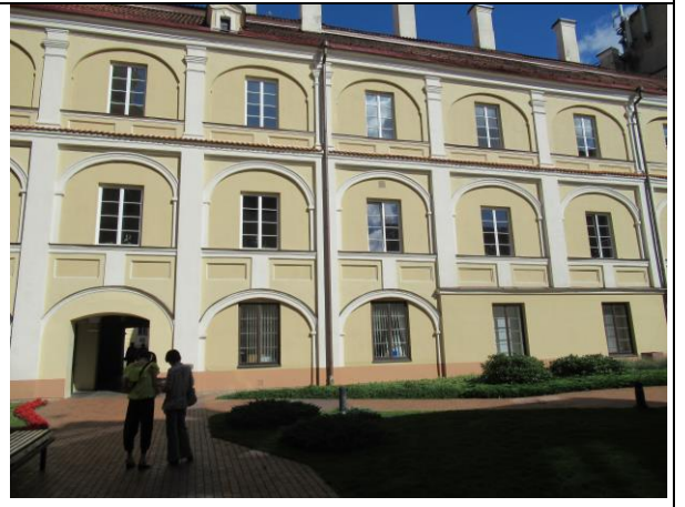
Wnętrze dziedzińca – przejście po lewej
